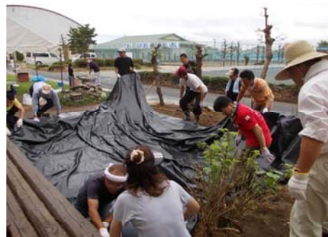
“ひょうたん池”の改修作業
